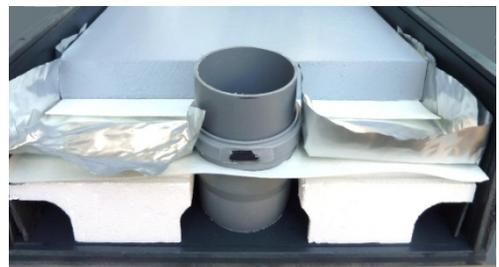
RadonProtect Folie mit Lüftungs-
